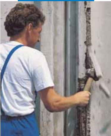
Demolizione del calcestruzzo degradato
