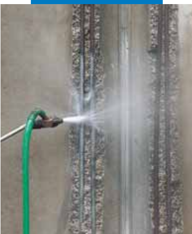
Pulizia dei ferri con idrosabbatura
